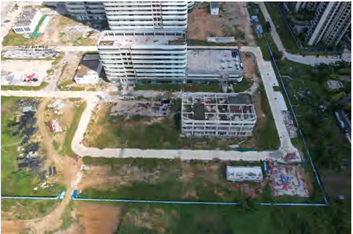
项目西北部现状 (2023年7月5日拍摄)
