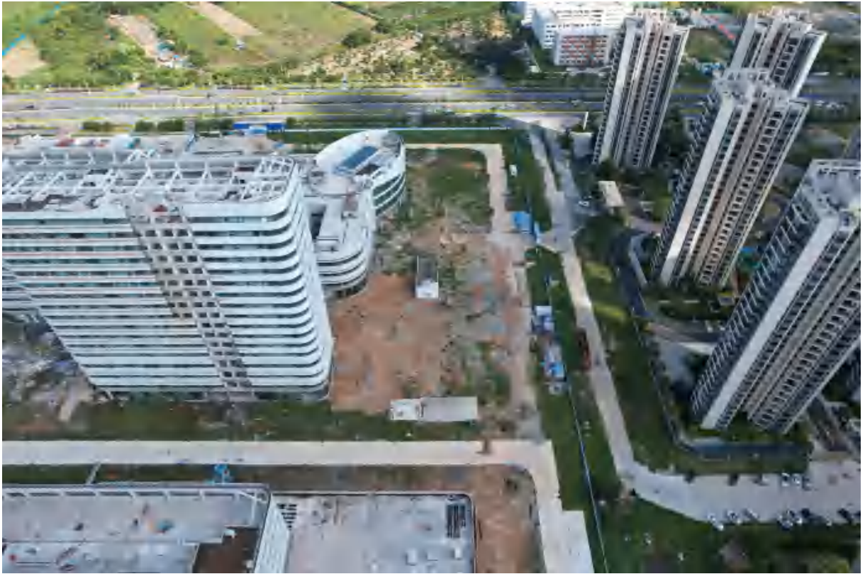
项目西南部现状 (2023年7月5日拍摄)
