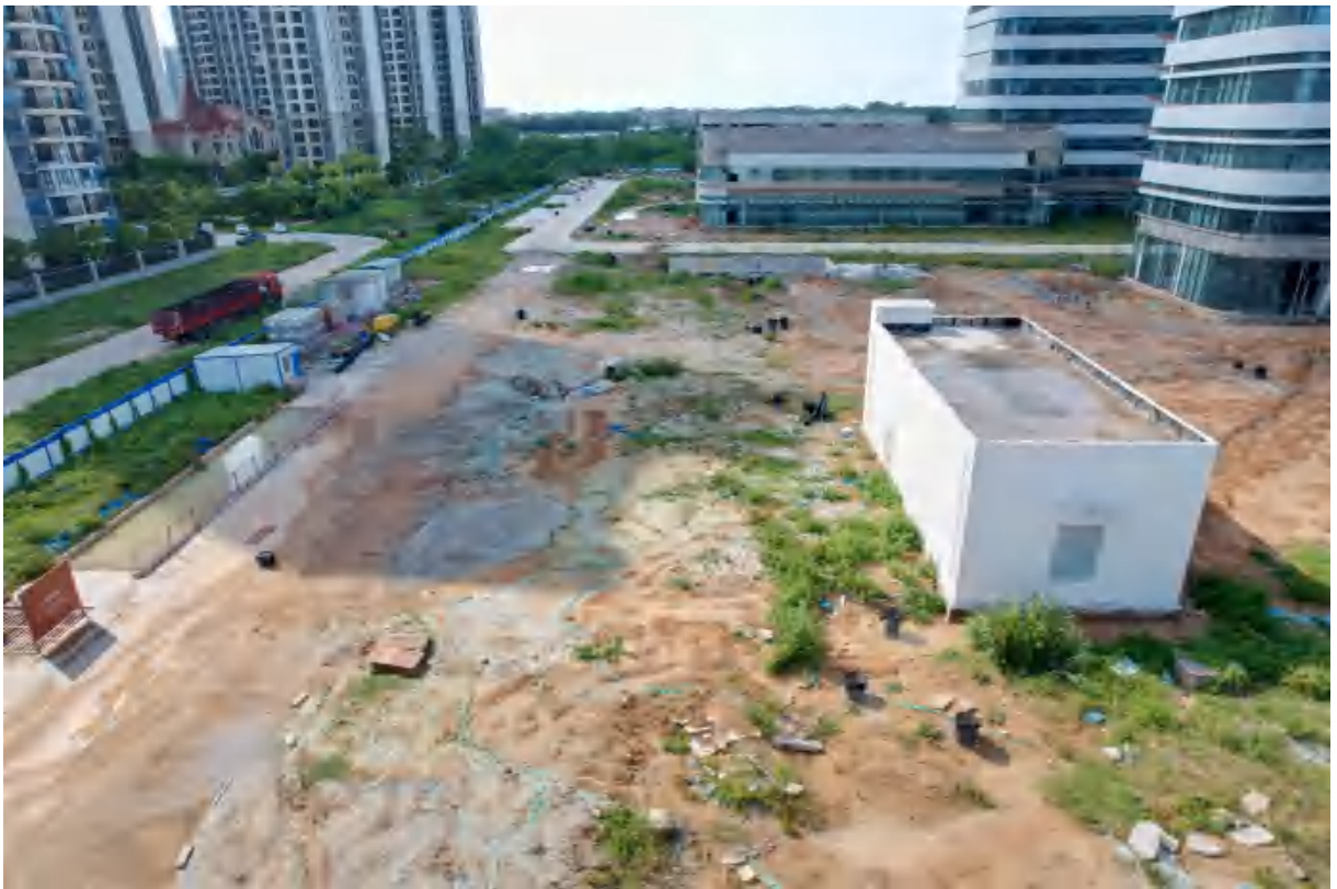
项目内部实施临时苫盖区域现状(2023年7月5日拍摄)
