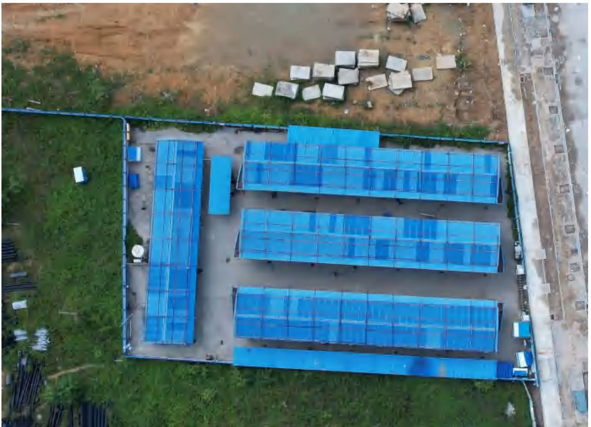
施工生产生活区现状(2023年7月5日拍摄)
