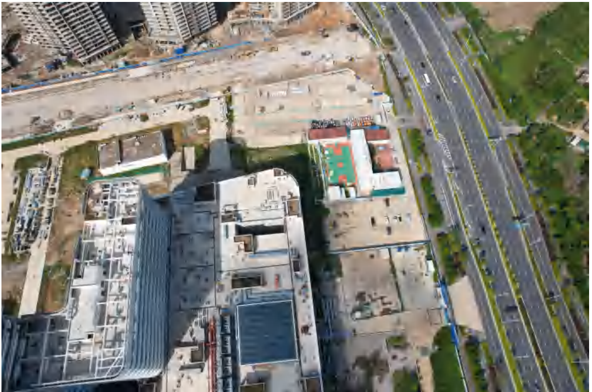
项目东南部现状 (2023 年 7 月 5 日拍摄)
