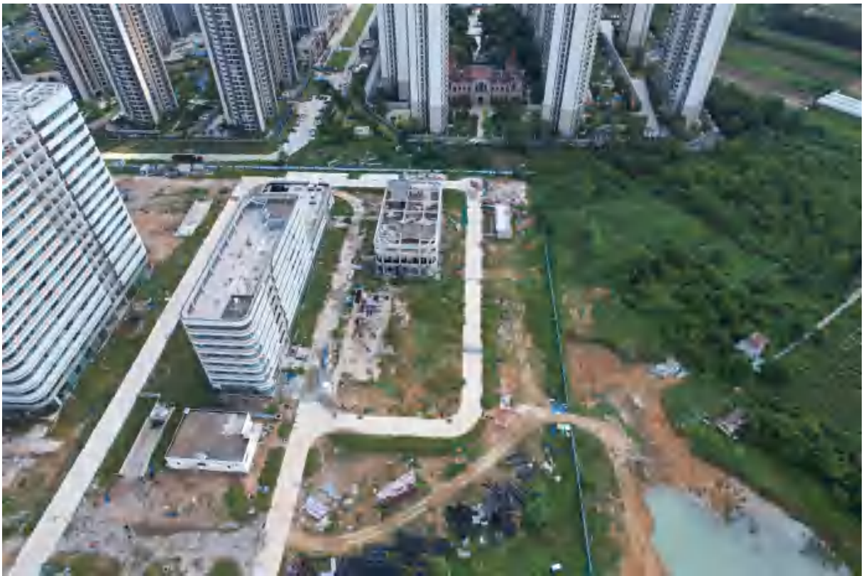
项目区临时堆土区现状(2023年7月5日拍摄)
