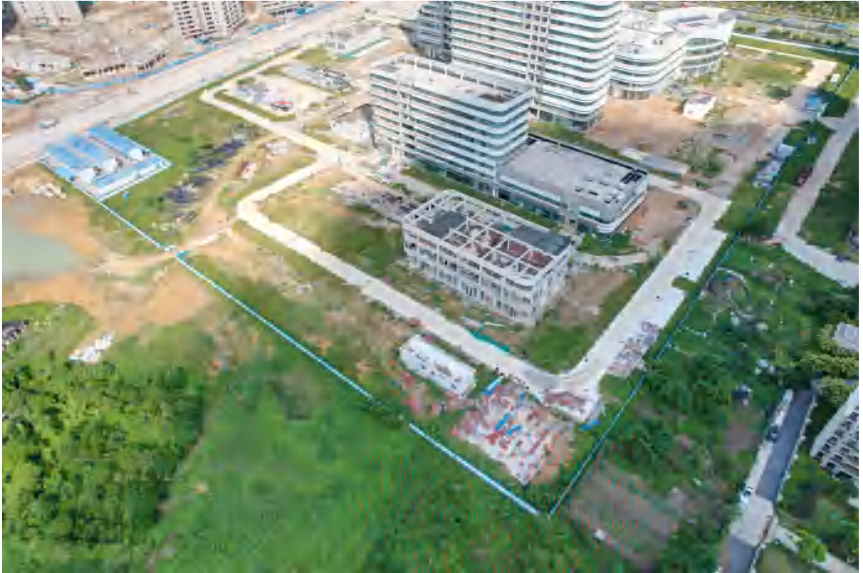
项目现状全景图 (2023 年 7 月 5 日拍摄)
