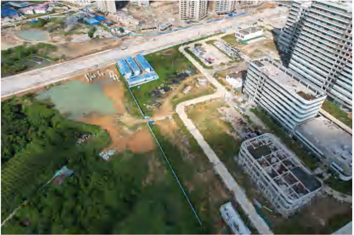
项目东北部现状 (2023年7月5日拍摄)
